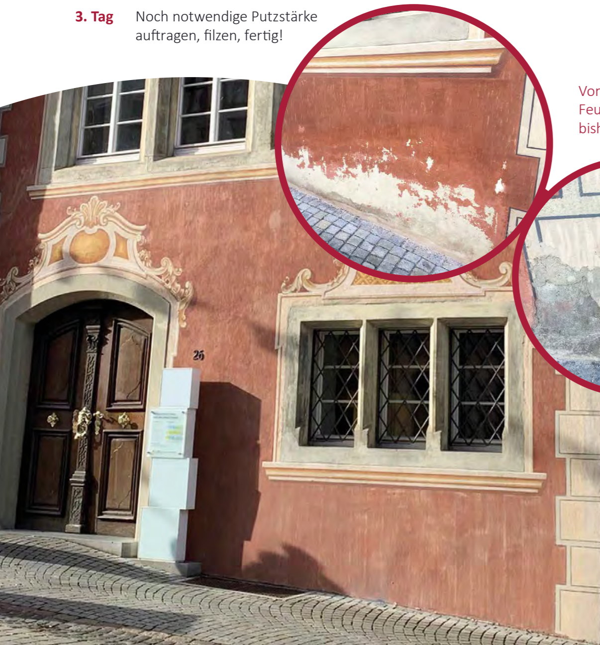
Jahre später (2023): Keine weitere Zerstörung durch Salze und Feuchtigkeit.
